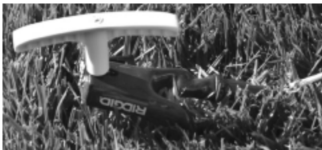
Рис. 7 – присоединение провода к заземляющему штырю
